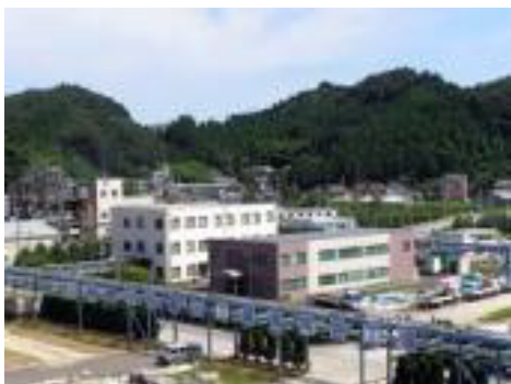
有機合成薬品工業(株)常磐工場(いわき市常磐西郷町)
