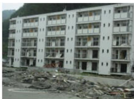
津波が3階まで来た公営住宅
