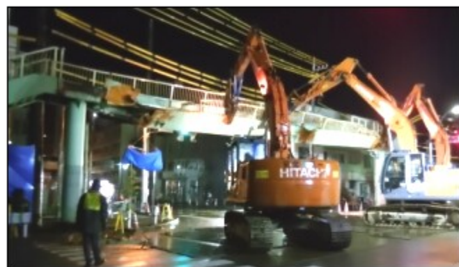
三台のバックホウにアタッチメント（恐竜のくちばし）をつけ、挟んで、引っ張り、引き剥がす
