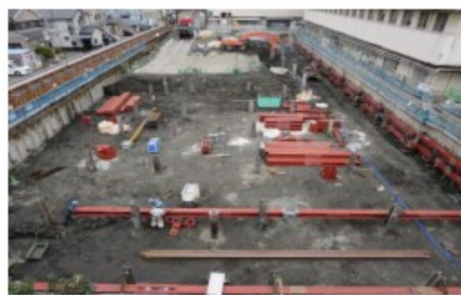
新病院建設工事が進められています。
