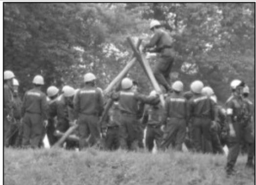
消防団が土手の決壊防止ため4ッ杵を作成中。現場の状況に合わせて工法を決めます（上）
