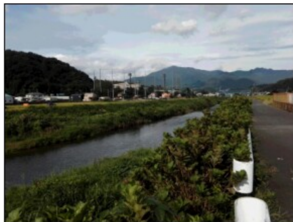
市内小野の工事箇所(玉川)。右側が衛生プラント、奥に見えるのが大山。
