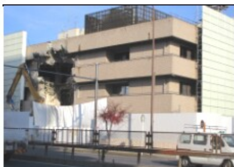
解体中の旧外来棟
