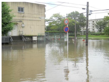
ゲリラ豪雨といわれる大雨で一帯が冠水したわしみや団地の2街区
