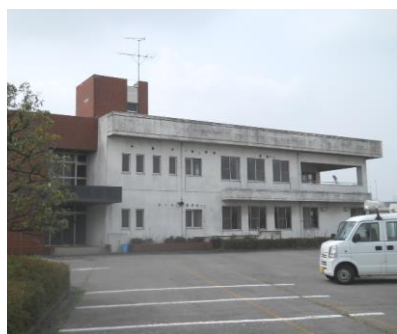
「第2庁舎」 旧幸手保健所跡
