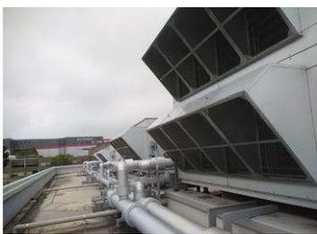
給食センター屋上の空調機。昭和鉄工の「エアハンドリングユニット」ダンパー内の銅管コイルが凍結、破損。
