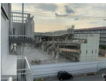
イオンの解体現場
