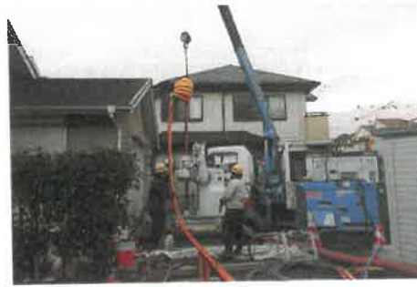
(写真3) 本施工に向けて
