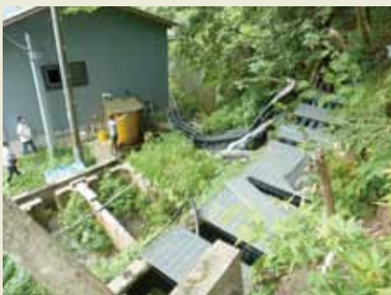
総会の翌日（9月2日）、京都府南丹市美山町「芦生山の家」の小水力発電施設を見学。パイプで水をひき、6メートルあまりの落差を活用して13キロワットの出力。「山の家」の30%程度の電力を賄えるという。かつては、この場所に京都大学の水力発電設備があった。
