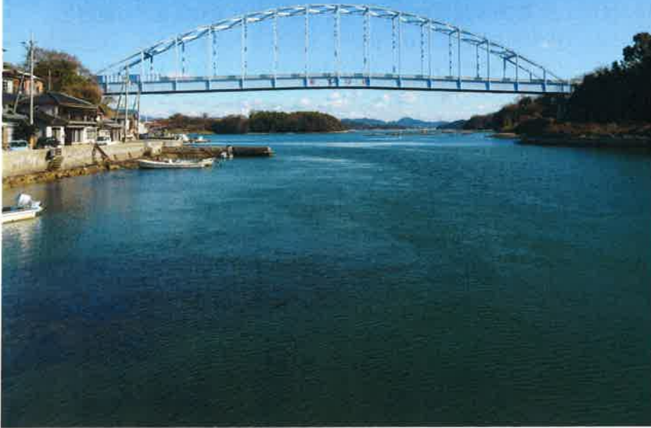
架橋30周年を迎えた、「人間回復の橋」 邑久長島大橋
