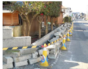
大谷石の塀の倒壊が多かった
