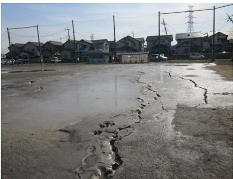
2013年5月頃から液状化対策実証実験が、震災時液状化した南栗橋スポーツ広場で実施されます
