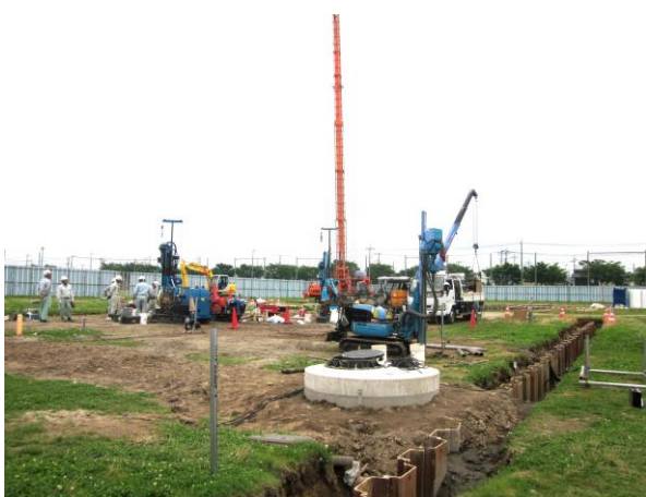
液状化対策実証実験「地下水低下工法」が実施されています (南栗橋スポーツ広場 6月24日)
