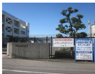
鷺宮浄水場 県水受水施設工事中
