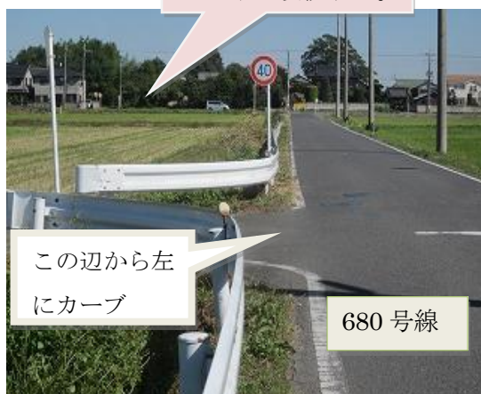
栗橋から東鷺宮へ向かう道路 市道680号線の拡張は
