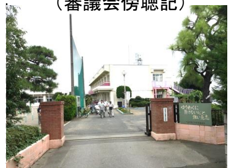
江面第2小学校の玄関から。
