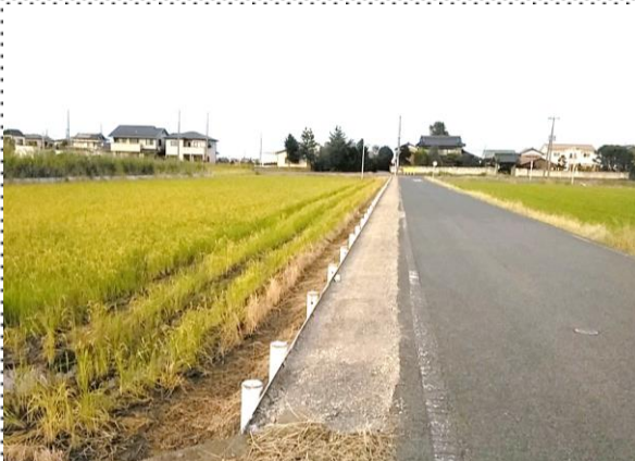
待ち望まれている道路整備
