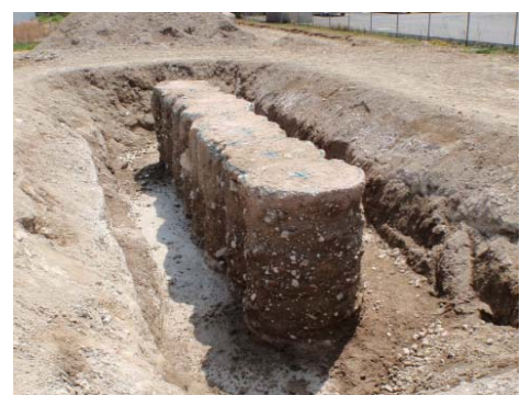
機械攪拌工法による改良体の 掘り出し調査例
